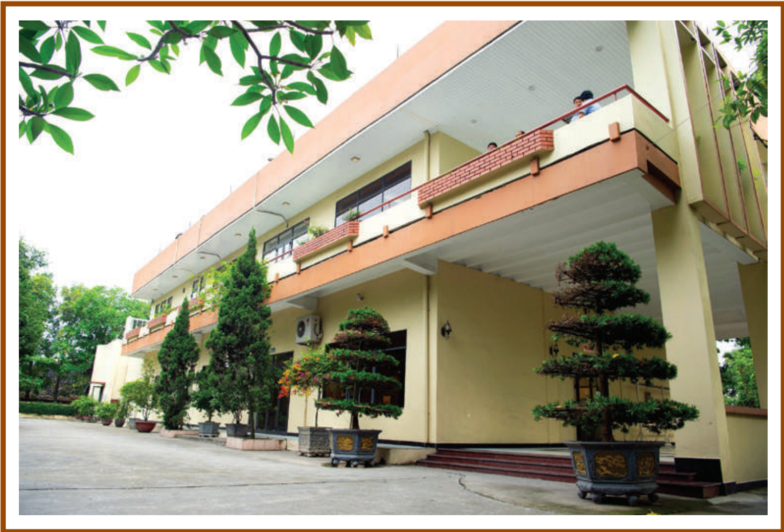
Nhà ăn ca được cải tạo, sửa chữa vào năm 2019.
